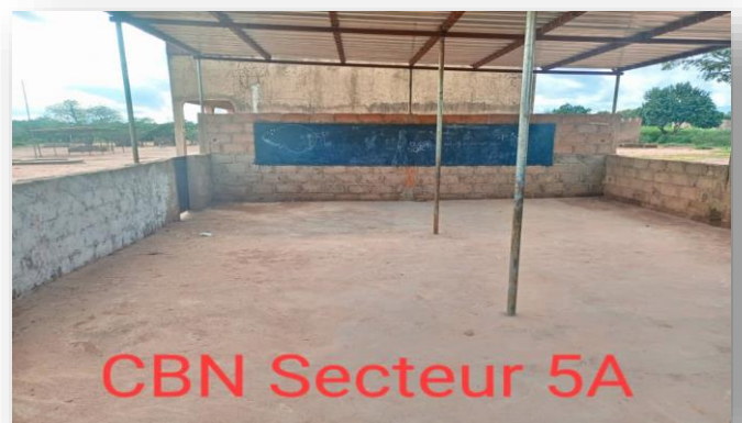
Un ETA mise en place à Orodara
